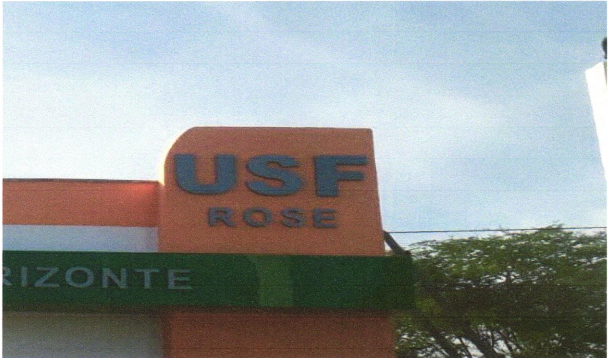
FOTO 05 – Letra em alumínio 45 x 45cm - instalado
