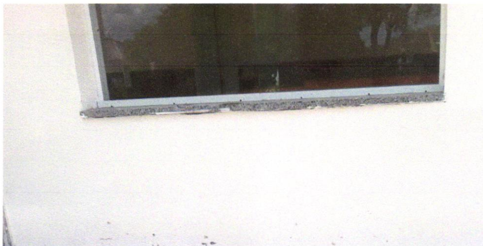
FOTO 17 – PEITORIL LINEAR EM GRANITO OU MÁRMORE, L = 15CM, COMPRIMENTO DE ATÉ 2M, ASSENTADO COM ARGAMASSA 1:6 COM ADITIVO. AF_11/2020
