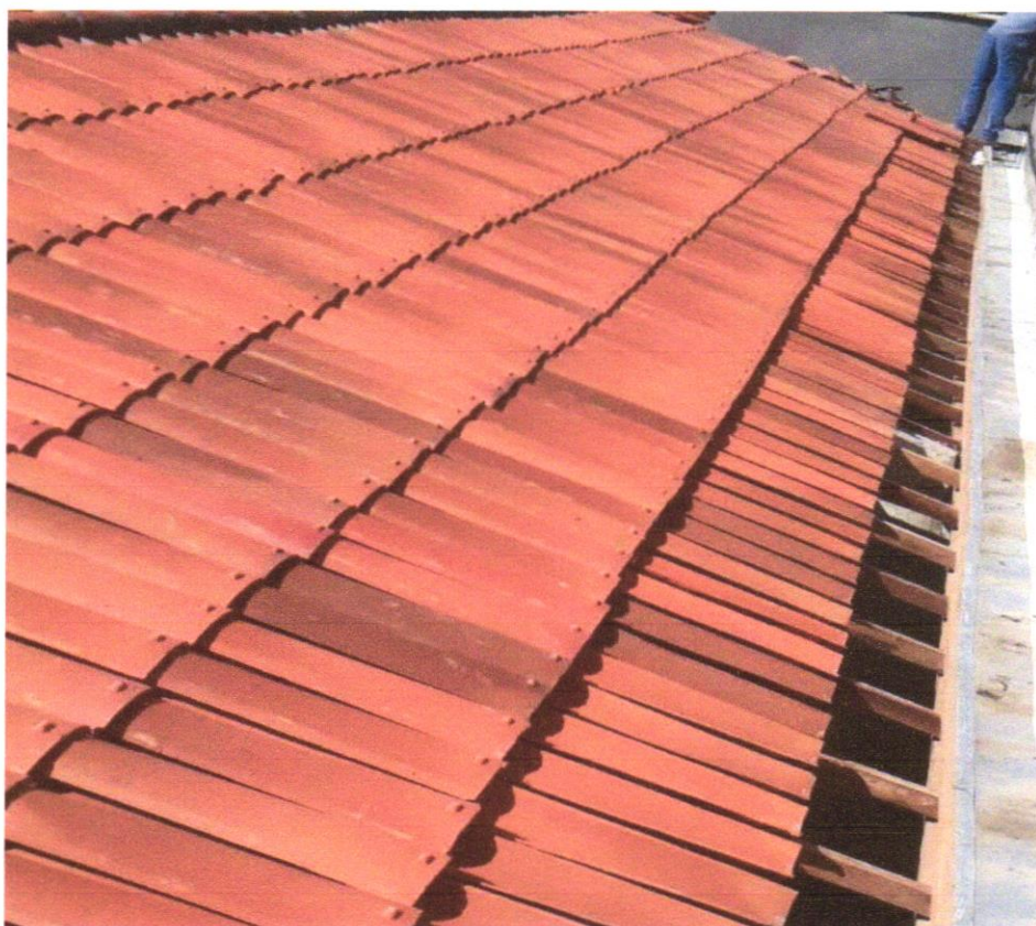
FOTO 18 – Retelamento em cobertura com telha cerâmica tipo canal comum, Itabaiana ou similar.
