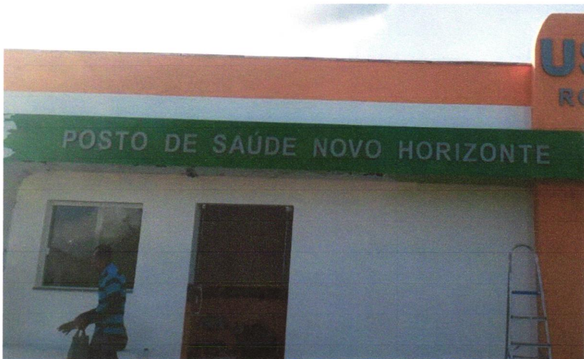
FOTO 04 - Letra em alumínio 20 x 20cm - instalado
