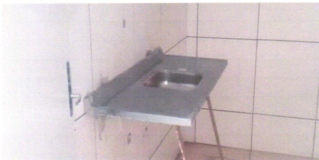
FOTO 28 – Pia de cozinha com bancada em aço inox, dim 1,20x0,60m c/ 01 cuba, válvula cromada, sifão cromado e torneira cromada, concretada e assentada. Rev.04
