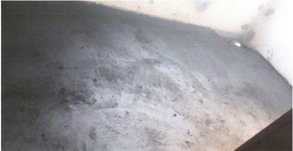
FOTO 09 – Contrapiso em argamassa traço 1:4 (cimento e areia), preparo mecânico com betoneira 400 l, aplicado em áreas secas sobre laje, não aderido, acabamento não reforçado, espessura 5cm. af_07/2021
