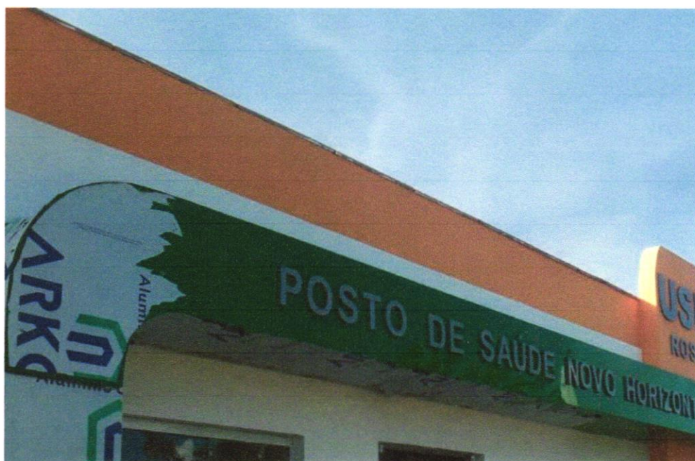
FOTO 02 – Chapim de concreto pré-moldado
